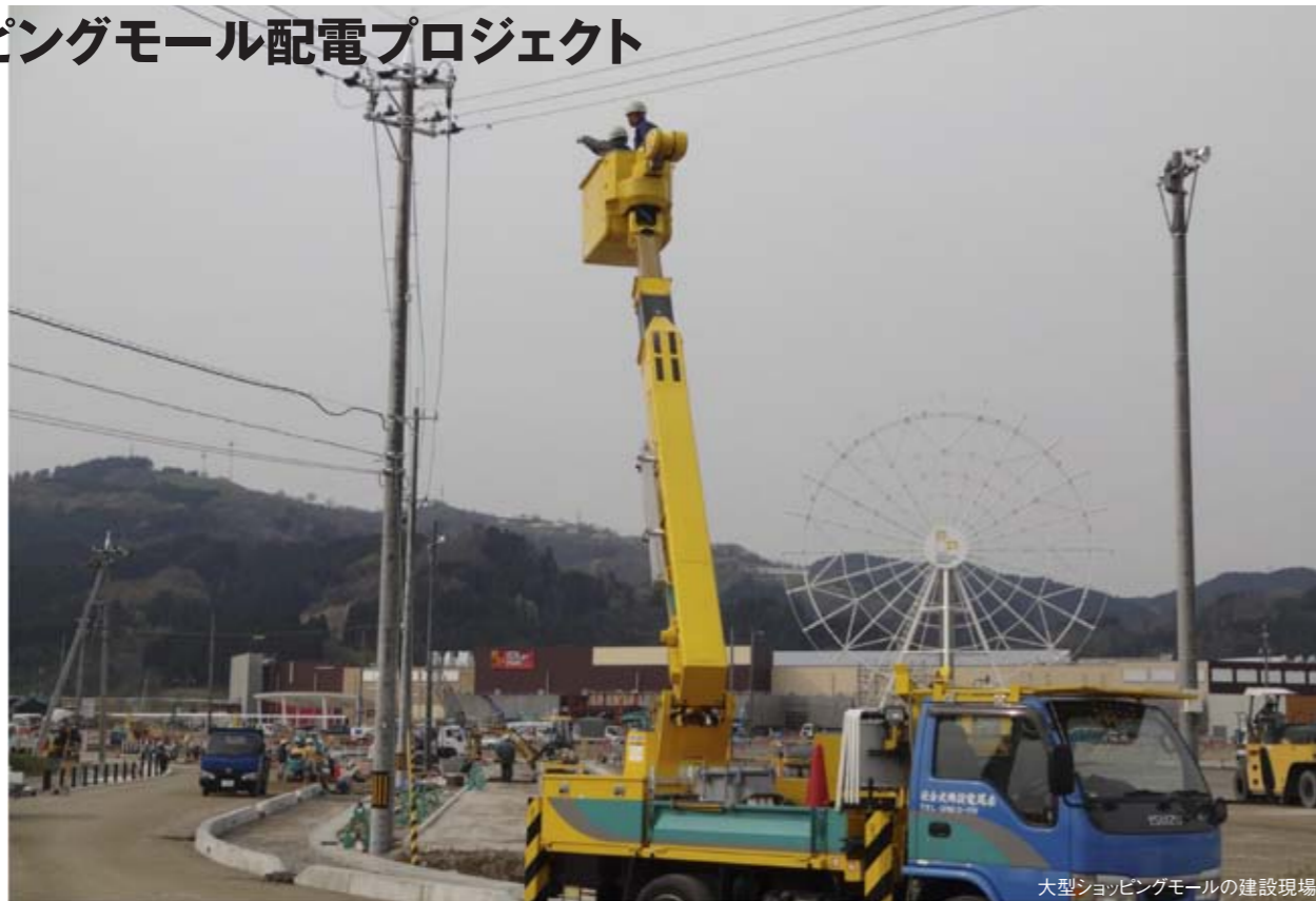
大型ショッピングモールの建設現場
