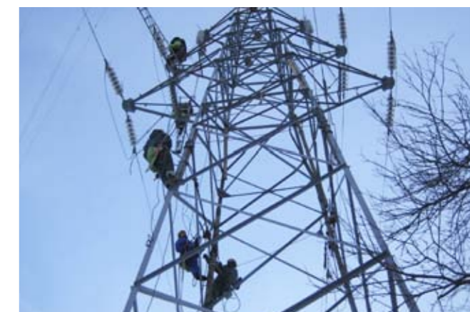
架線に絡んだ飛来物を撤去するため高所に行く
