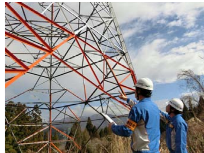
鉄塔の保守点検
