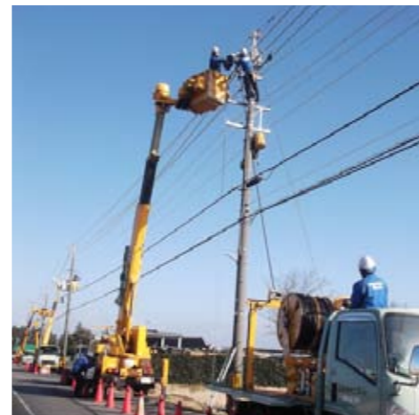
ドラムから電線を引き出して電柱に繋いでいく配電マン
