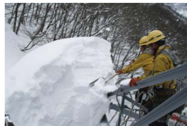
雪害による架線への損傷を防ぐための除雪作業
