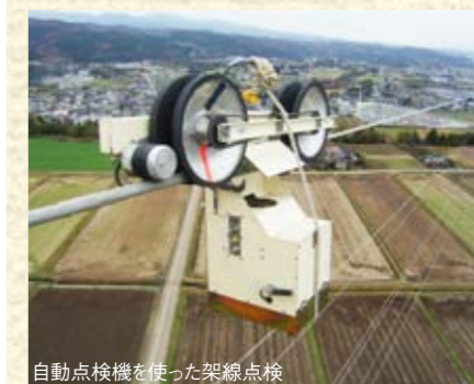
自動点検機を使った架線点検
