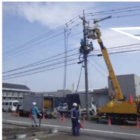
変圧器工事で新しい街へ電気を送る
