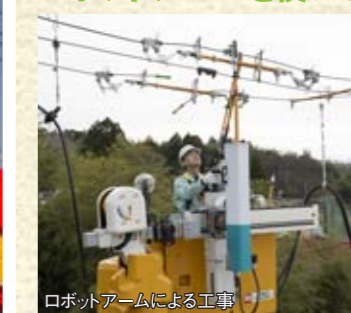
ロボットアームによる工事
