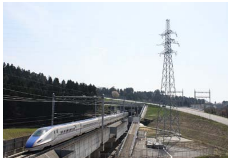
新幹線の変電所へと向かう送電線と送電鉄塔
