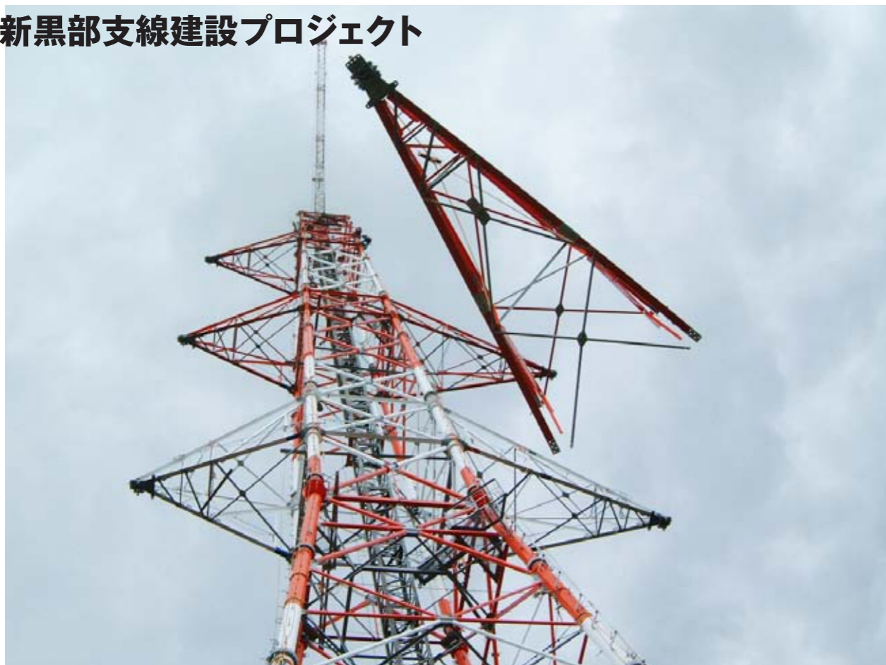
大型クレーンなどを用いた鉄塔組立工事
