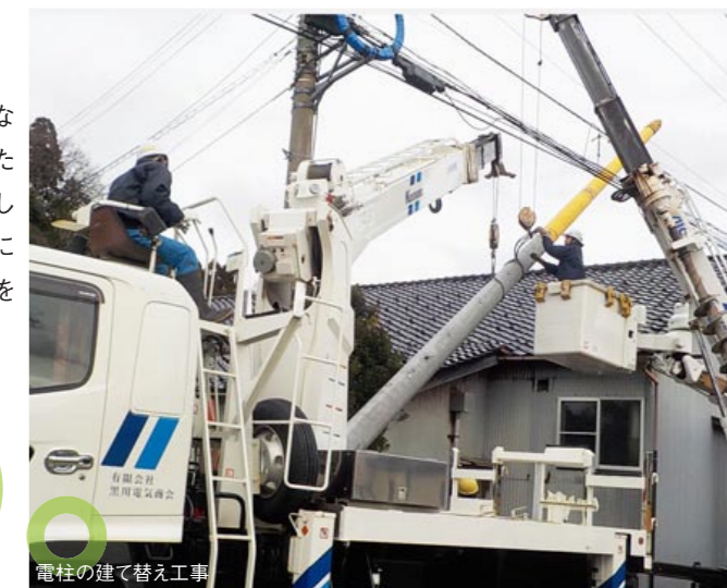
電柱の建て替え工事
