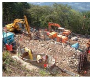
鉄塔を建てるための基礎工事
