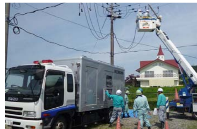
停電した地区の応急対策として、高圧発電機から電気を送る
