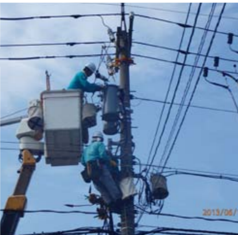
ドラムから電線を引き出して電柱に繋いでいく配電マン
