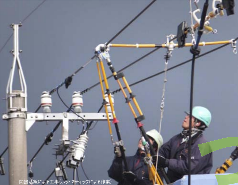
間接活線による工事(ホットスティックによる作業)
