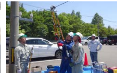
地上模擬線での電線被覆剥ぎ取り練習
